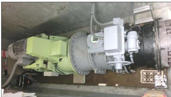
水車と発電機]水流は円筒の中を右から流れ中のプロペラ水車を回す。水車の回転がベルトで発電機(左の上)を駆動する。↑
